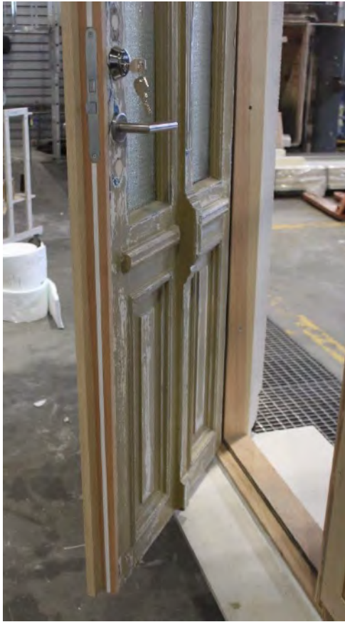
Foto 4: Bildene viser innfelt volumøkende list på sidene av dørblad samt sort tetningslist i karm.
