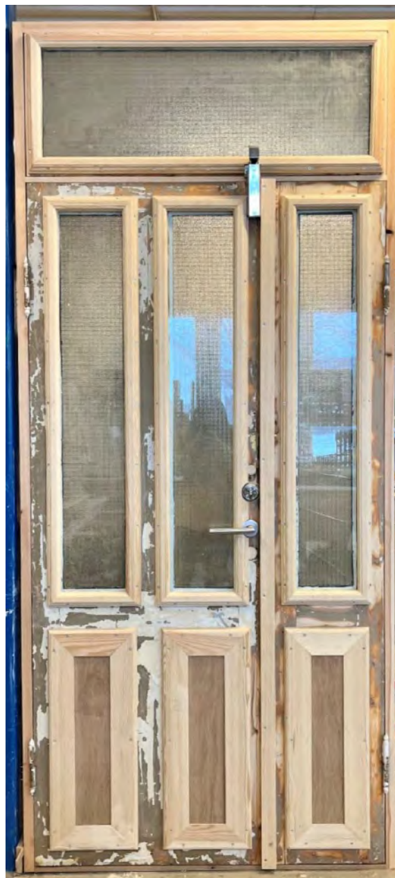
Figur 5 Testdør utside etter oppgradering. Foto: Caroline Lundegaard Hannisdal/Murbyen Oslo
