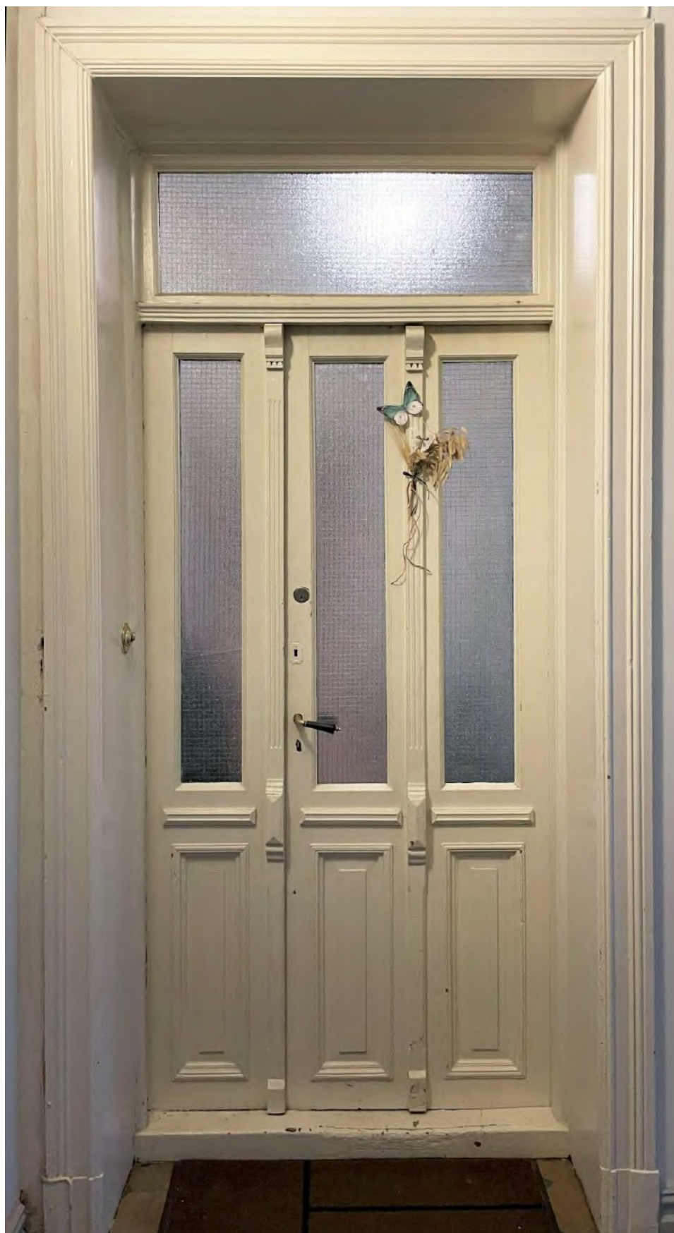
Figur 1 Testdør før demontering, utside. Foto: Caroline Lundegaard Hannisdal/Murbyen Oslo
