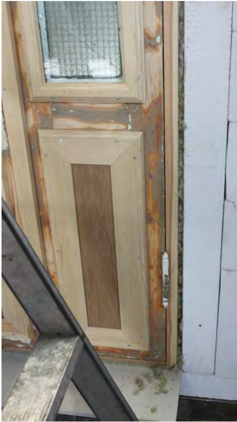
Foto 1: Bilde til venstre viser dytting med steinull mellom karm og vegg. Bilde til høyre viser fuging over isolasjonsdytten.
