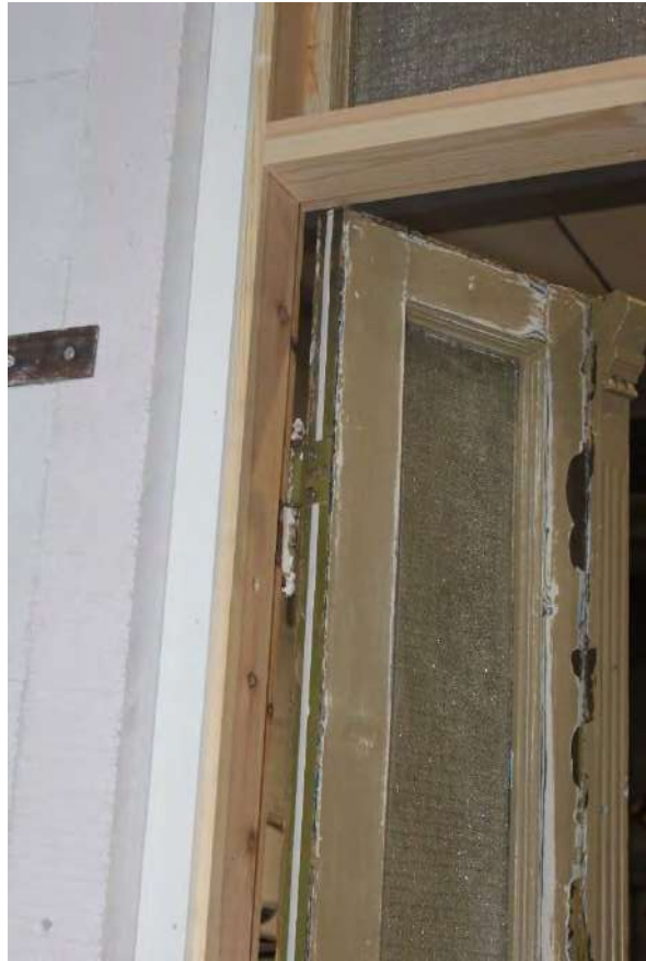
Foto 4: Bildene viser innfelt volumøkende list på sidene av dørblad samt sort tetningslist i karm.
