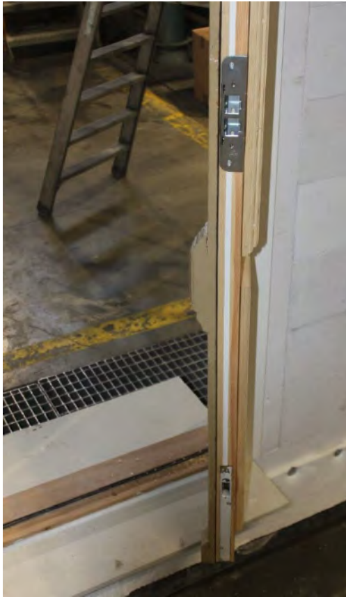
Foto 5: Bilde til venstre viser passiv fløy med innfelt volumøkende list, sluttstykke og kantskåte. Bilde til høyre viser toppen på aktiv fløy med innfelt volumøkende list og dørlukker.
