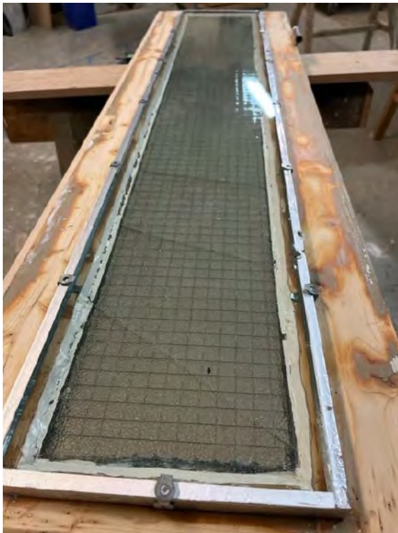
Figur 3 Glasset, levert i aluminiumsramme, ble festet med tilklipte hullbånd og skruer. Skruene ble satt rett ned i ramtreet. Foto: Kris & Kjells Møbelsnekkeri AS
