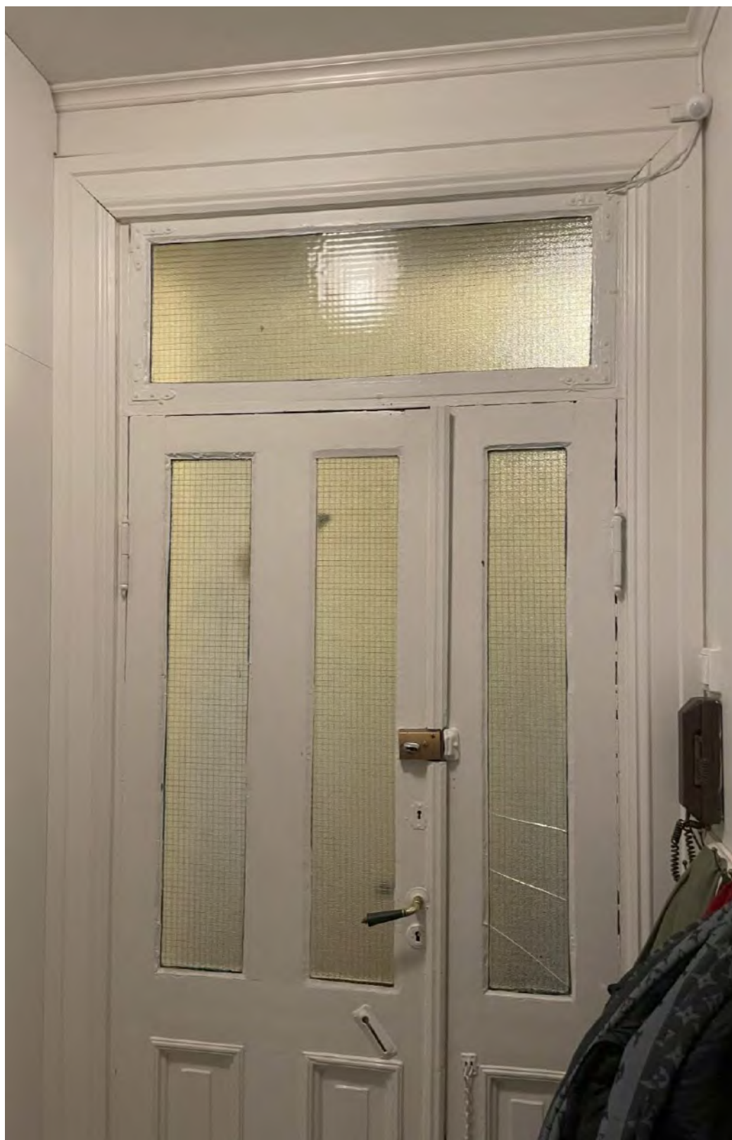
Figur 2 Testdør før demontering, innside. Foto: Caroline Lundegaard Hannisdal/Murbyen Oslo
