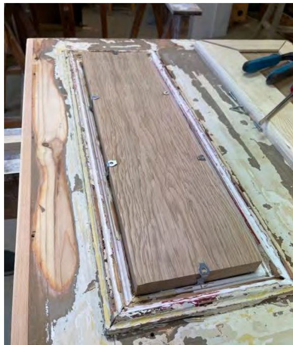
Figur 3 Glasset, levert i aluminiumsramme, ble festet med tilklipte hullbånd og skruer. Skruene ble satt rett ned i ramtreet. Foto: Kris & Kjells Møbelsnekkeri AS
