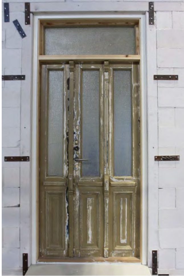
Foto 2: Spalten mellom karm og vegg er dekket av listverk på sidene og i toppen.
