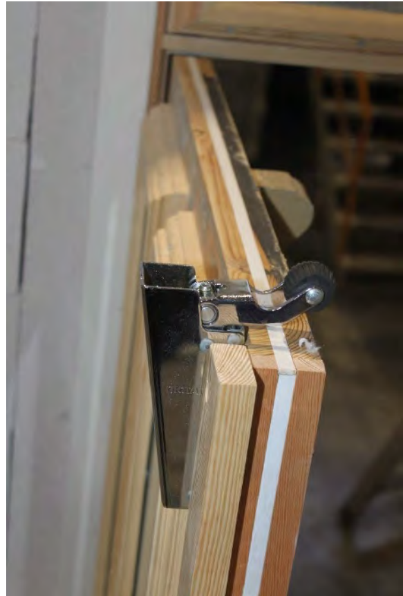
Foto 5: Bilde til venstre viser passiv fløy med innfelt volumøkende list, sluttstykke og kantskåte. Bilde til høyre viser toppen på aktiv fløy med innfelt volumøkende list og dørlukker.
