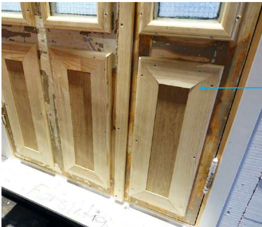
Figur 7 På baksiden av døren ved målepunkt TC25. Øvre list ligger ikke i plan med de to vertikale listene i hjørnene og det har trolig vært en avstand mellom listen og treplaten. Kanskje har dette forårsaket den lokale temperaturstigningen ved TC25. Foto: André Korsaksel/Byantikvaren i Oslo
