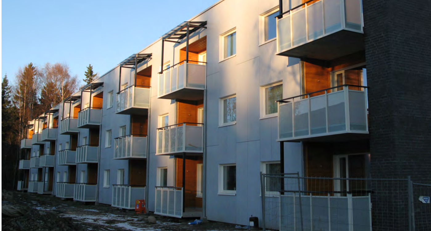
Myhrerenga borettslag etter oppgradering. Foto: SINTEF Byggforsk
