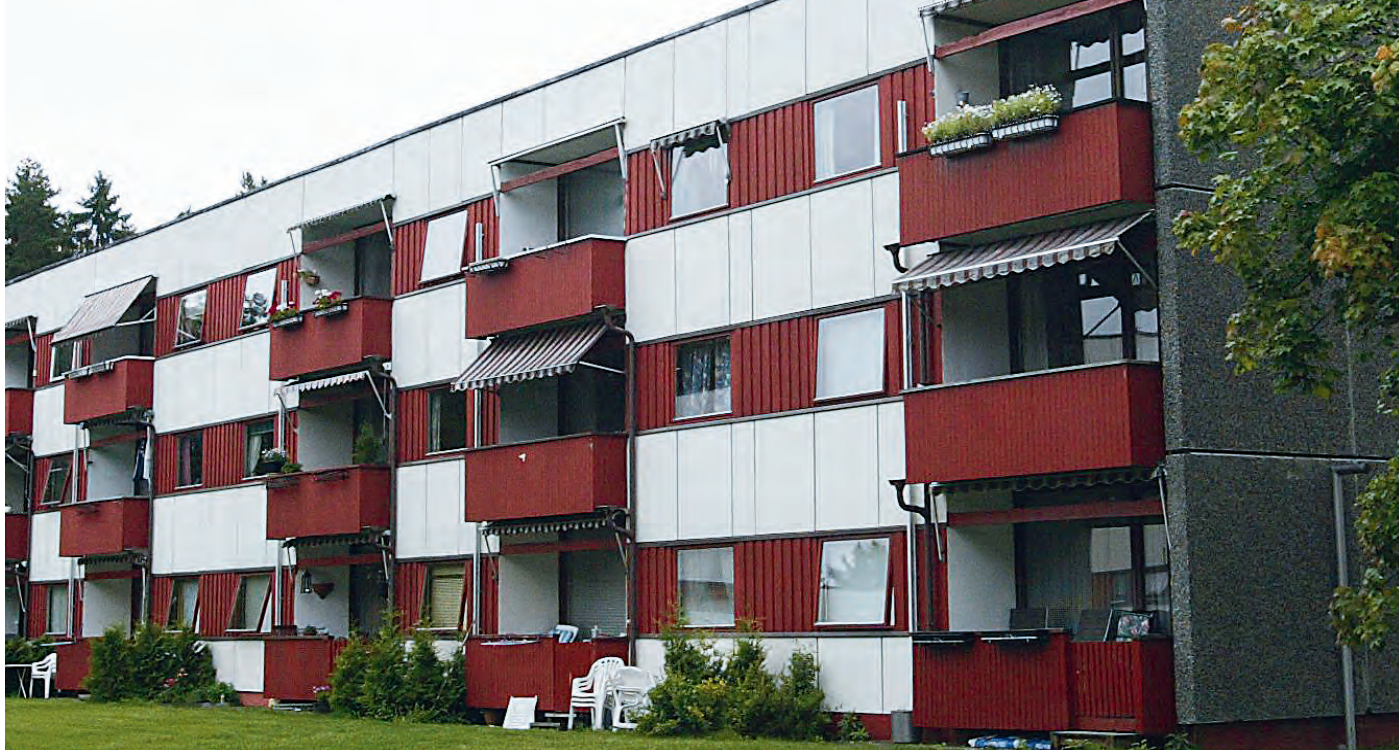
Myhrerenga borettslag før oppgradering. Foto: Arve Brekkaus/Byggeindustrien
