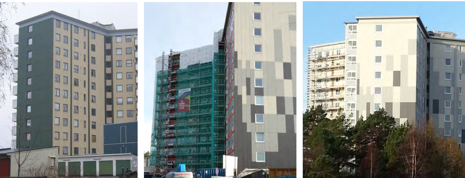
Stjernehus borettslag før, under og etter oppgradering. Foto: Sørlandet boligbyggelag
